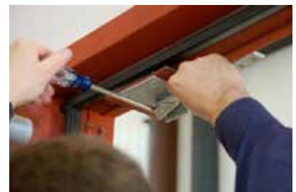
Step 21 - Install Door Closer Arm
