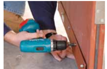
Step 27 - Install Super H Door Bottom
